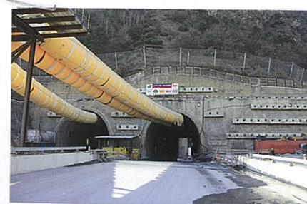
Portal Chatzuhüs des Tunnels Visp mit Frischluftzufuhr (Lutten) für den Untertagebau.
