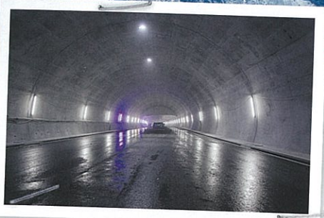
Fertig betonierte Verzweigung im Tunnel Eychholz: 26 m Spannweite!
