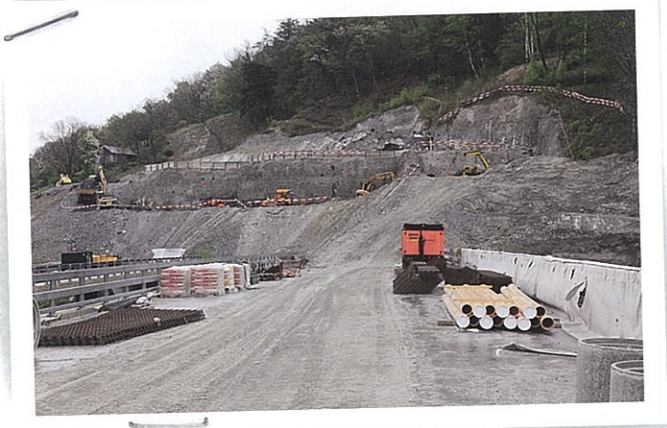
Am Riedberg sind die Stabilisierungsmassnahmen beim Portal West abgeschlossen.
