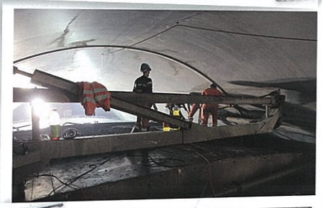
Bau der Zwischendecke im Tunnel Eychholz.
