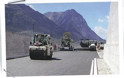
Erster Belagseinbau im Gedeckten Einschnitt Turtmann (April 2015).
