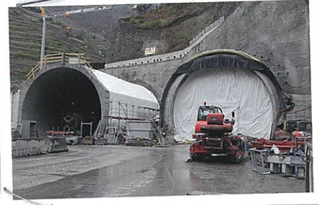
Das Portal Staldbach des Tunnels Eychholz.
