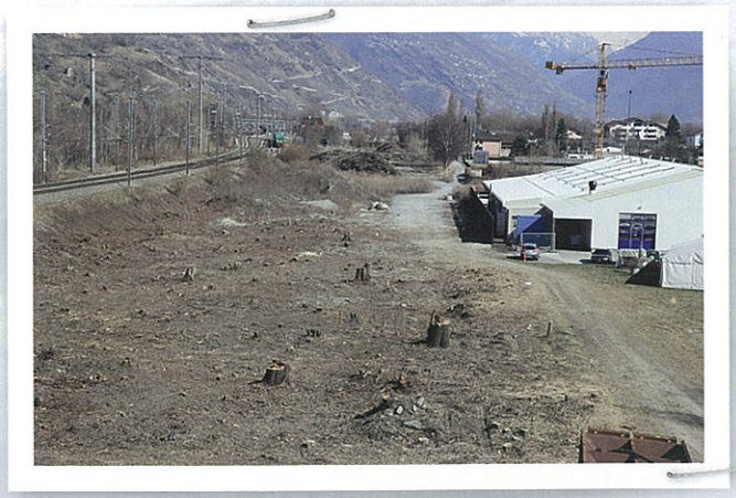
Rodungsarbeiten als Vorbereitung für den Bau des Gedeckten Einschnittes Raron.
