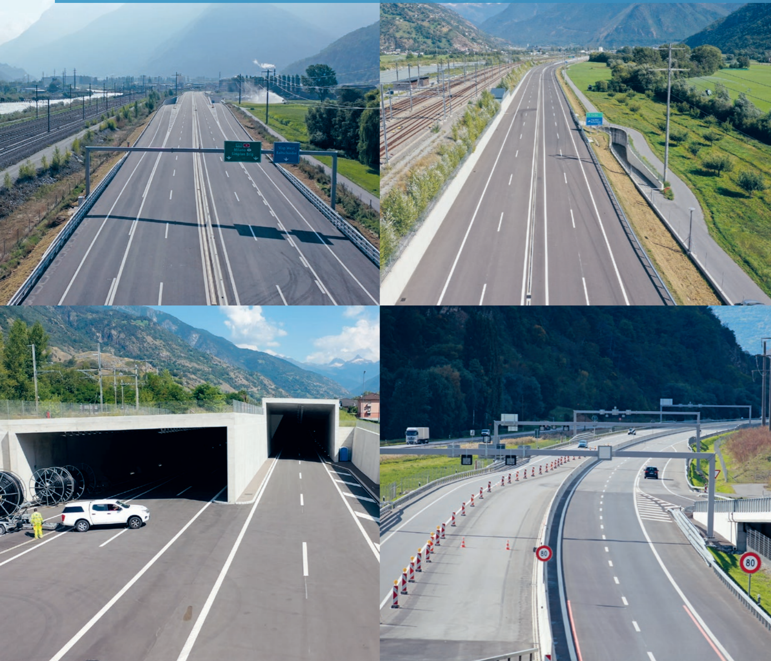
Oben links: Fertig signalisiertes Trasse vor Visp - West. Unten links: Verkabelungsarbeiten im Gedeckten Einschnitt Raron.
