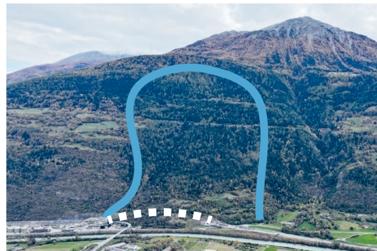
Die Sackung des Riedbergs mit der Linienführung des Riedberg-Tunnels unten. Der Hang rutscht auf einer plastischen Gleitschicht aus Graphitschiefer auf halber Höhe des Hangs. Der Tunnel Riedberg ist nicht der Auslöser für diese Hangverschiebungen.
